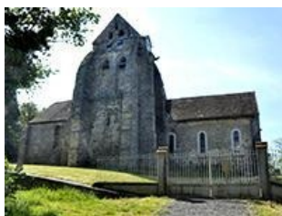
Photo extérieure de l'église
